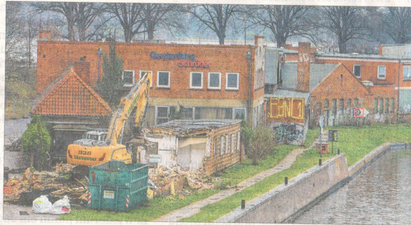
Das ehemalige Grundstück der Firma Gerstenberg-Schröder wird dem Erdboden gleichgemacht – für Wohnraum. Foto: Wolfgang Maxwitat
