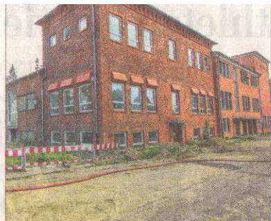
Die alte Verwaltung und das Labor werden zuletzt abgerissen. Die Anlage wurde lange als Notlösung betriebsbereit gehalten.
