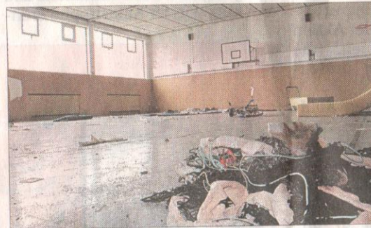
Viele Teile der Turnhallen-Einrichtung wurden von ungebetenen Besuchern zerstört.
