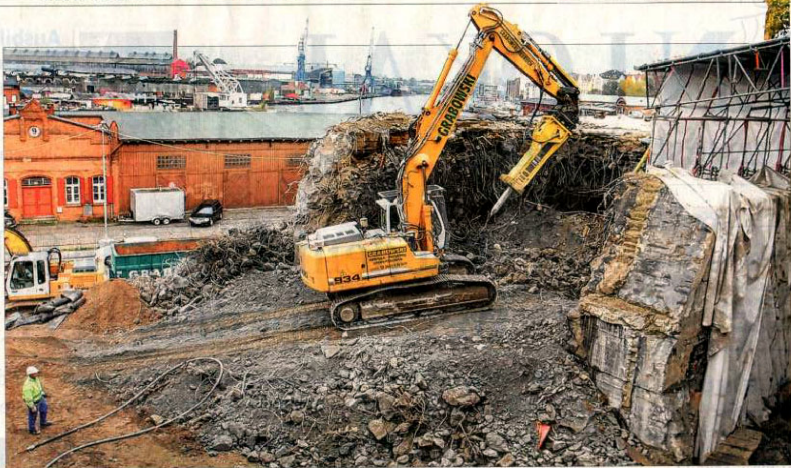
Ein Bagger macht den ehemaligen Luftschutzbunker an der Untertrave dem Erdboden gleich.
