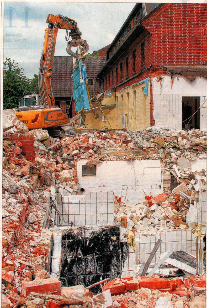
Maschinist Heiko Fronder steuert seinen 30-Tonner „Liebherr 926“ sicher über die Schuttberge. Mit dem Sortiergreifer schwenkt er einen Holzvorbau der alten Jugendherberge auf den richtigen Haufen. Fotos: Hanno Hannes
